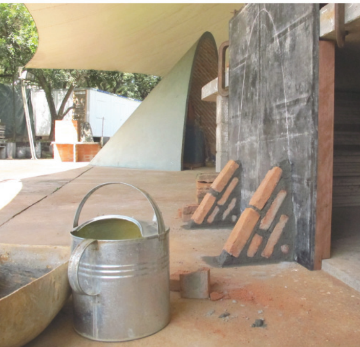
6 O primeiro tijolo é colocado em pé, contra a parede.
