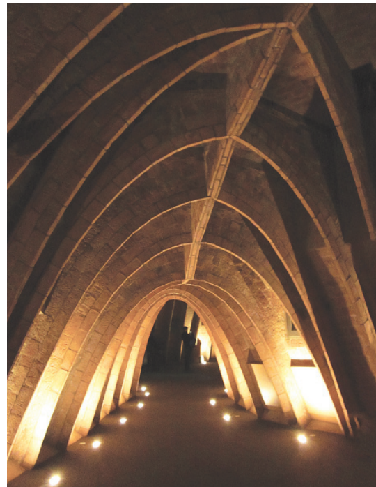
15 1906-12, Casa Milà. Arq. Antoni Gaudí.
