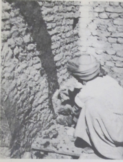
6 O primeiro tijolo é colocado em pé, contra a parede.
